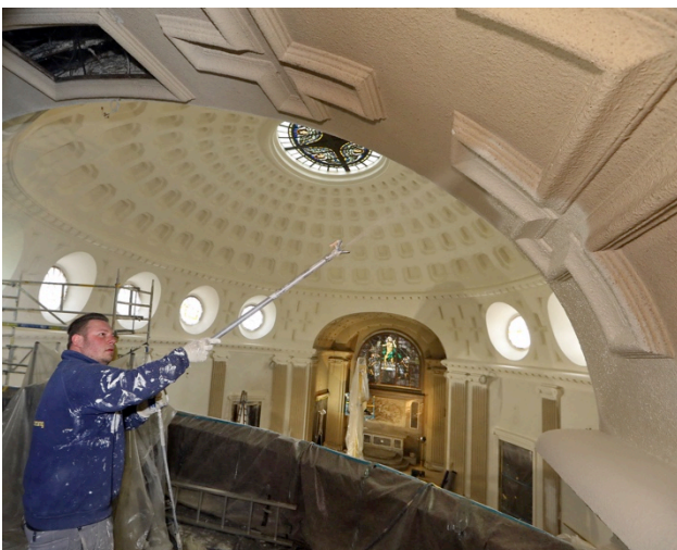
Farbspritzprobe auf der Empore
