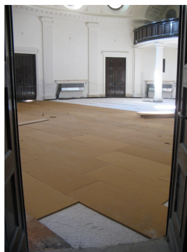
Fensterabschluss am 9.4. Hallenboden am 10., Einbringung der Dämmung am 11.
