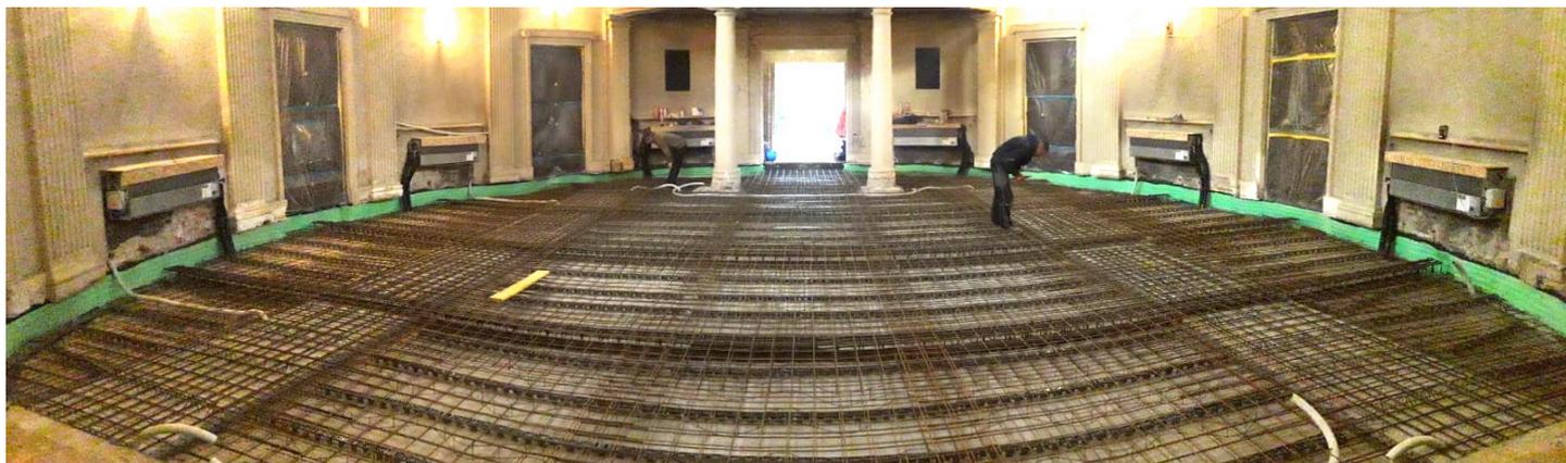
Zustand Neue Halle am 20.02.19, Eisenbewehrung für Betonfußboden
