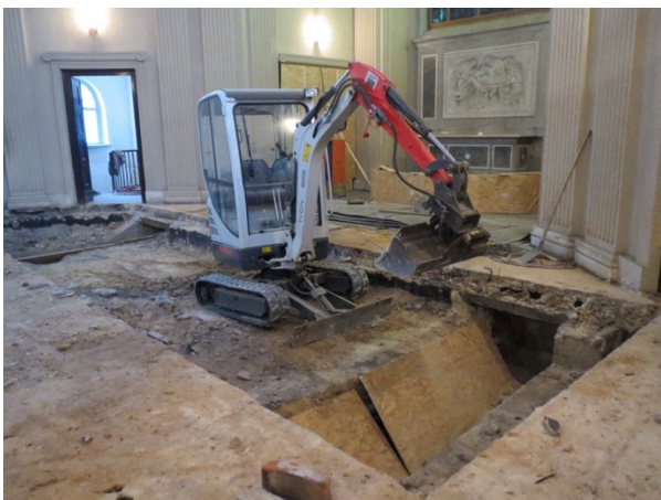
Entfernung des schadhafte Unterbetons
