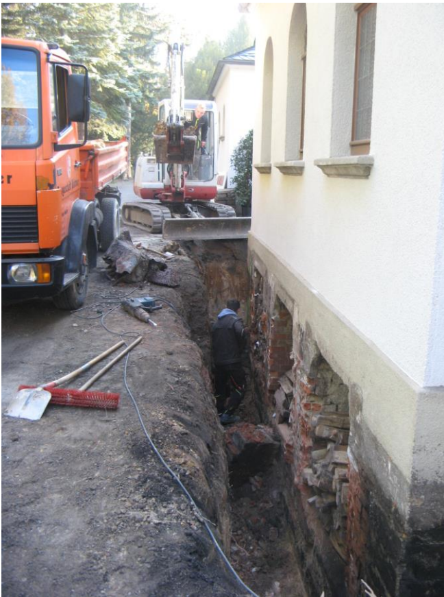
Arbeiten der Firma Büttner/Müller am Sockel der Neuen Friedhofshalle mit Trockenlegung, Entwässerung und Geländeregulierung
