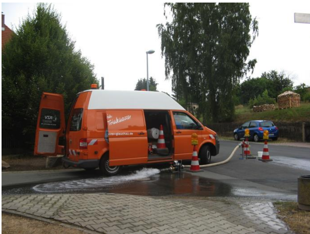
Spülung der Wasserrohre
