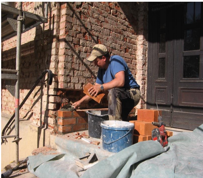
Ersetzen der schadhafte Ziegel am Portikus durch die Firma Löwen-Restaurierung aus Flöha
