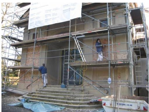
Die Bauarbeiten am letzten Außenabschnitt, dem Portikus, sind am 14. März unter Nutzung von zwei frostfreien Tagen begonnen worden. Der schadhafte Putz wurde entfernt. Erst bei höheren Temperaturen kann mit dem Anbringen des neuen Putzes begonnen werden. Dabei wird der Zugang zur Halle für Trauerfeiern erhalten. Alle Bauphasen werden für eine Ausstellung in einer späteren Fotodokumentation festgehalten.
