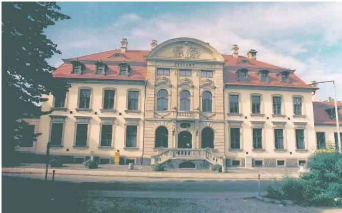
Ehemaliges kaiserliches Postamt Meerane, Foto: Augsten, Meerane
