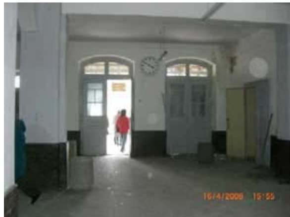
Bahnhofshalle Blick Richtung Bahnsteig
